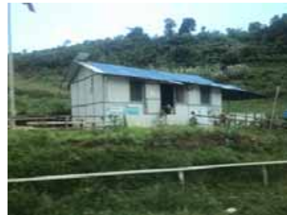
ユニセフによる屋根の補修だそうです
